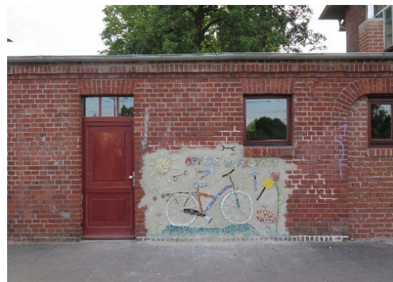
Klima.Anbau mit Fahrradwerkstatt (Quelle: Plg)
